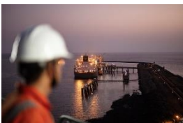
Hazira LNG (liquefied natural gas), India. Photo Courtesy Shell
