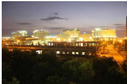
Dahej LNG terminal – Illustration purposes only (Image courtesy of Petronet LNG)
