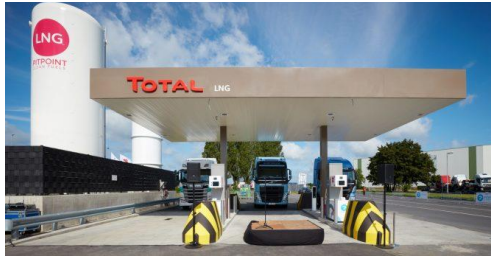
Image courtesy of PitPoint LNG
